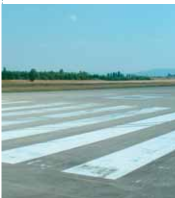
Die Pistenschwelle ist auf der Lande- oder Startbahn durch eine Reihe weisser Streifen markiert. Sobald sie erreicht ist, kann der Pilot ein Lande- oder Startmanöver einleiten. Auch eine bei der Landung versetzte Schwelle wird befeuert.
